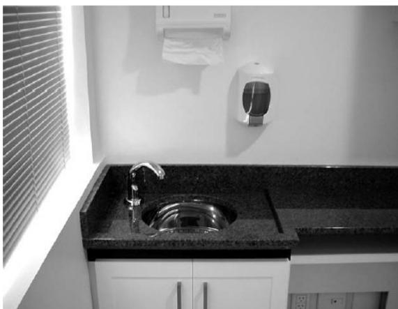
Fig. 6-3. A pia deve estar inserida em bancada e a torneira deve ser automática, com sensor. É recomendável a existência de um sistema de dispensação de papel toalha e sabão líquido.
